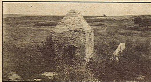
El deterioro de nuestras fuentes es común a toda la Colonia. En la foto, Fuente de Herrería.
