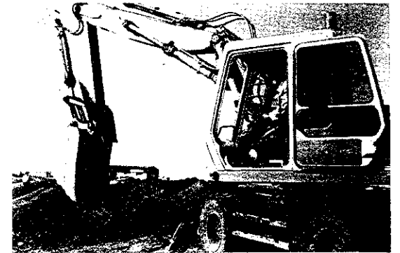
Comenzaron las obras del polígono industrial
