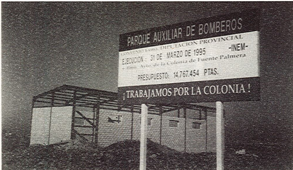
Estado actual de la obra del parque auxiliar de bomberos
